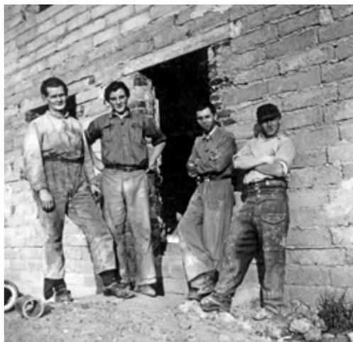
Sämtliche Steine für die Außenmauern wurden ebenfalls selbst hergestellt. In Holzformen wurde eine ausgeklügelte Betonmischung hineingepresst, das Ergebnis dann zum Trocknen auf Holzpaletten gestapelt. Bis zu 1.000 – dank Hohlraum – wärmeisolierende Dreiecksteine am Tag kamen so zu stande.
