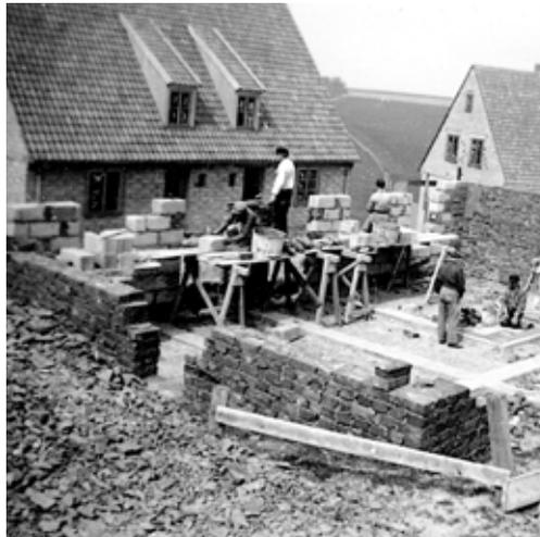
Baumaschinen oder Fahrzeuge standen so gut wie nicht zur Verfügung. Die Stadt lieferte Split, Rheinsand und Zement an. Das alles wurde von Hand gemischt und in die ausgehobenen Fundamentgräben geschüttet.
